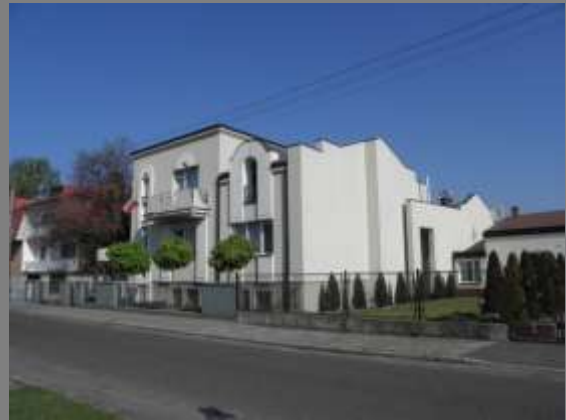
Dom jednorodzinny po przebudowie
