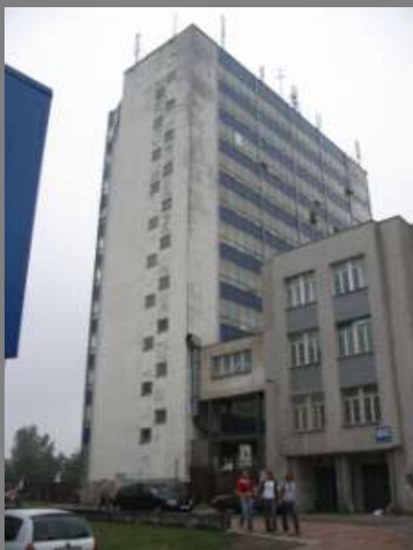
Kompleks biurowy przed przebudową
