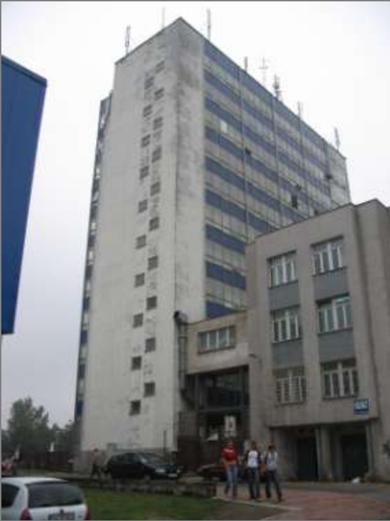
Kompleks biurowy przed przebudową
