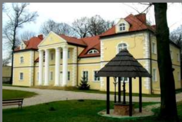
Pałac w Radoszewnicy po przebudowie
