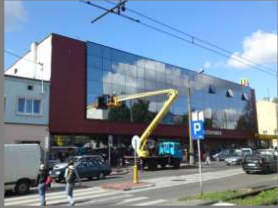
Dom Handlowy CENTRUM po przebudowie
