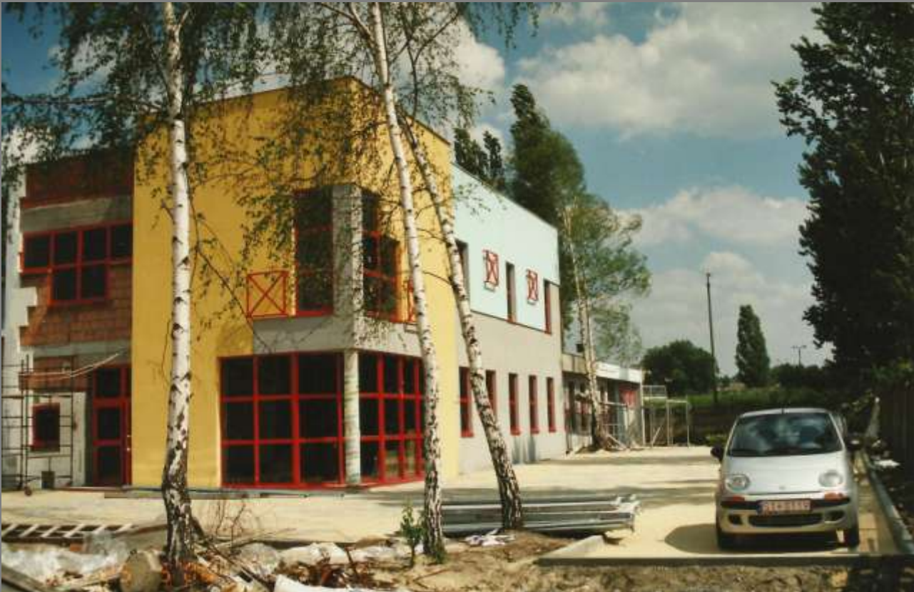
Budynek biurowo-magazynowy w Częstochowie
