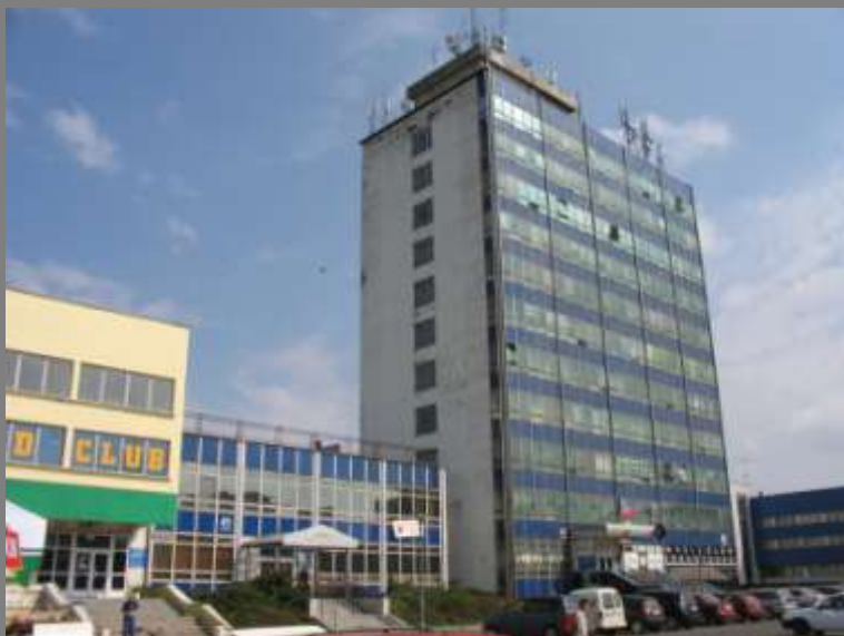
Kompleks biurowy przed przebudową
