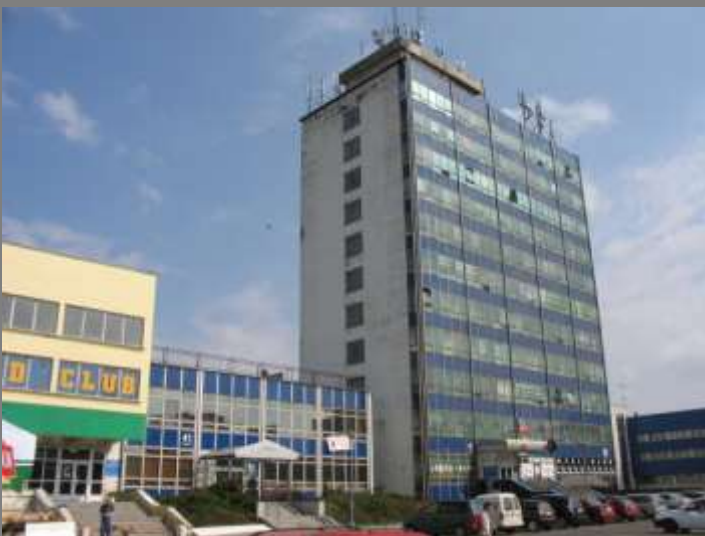
Kompleks biurowy przed przebudową
