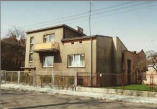
Dom jednorodzinny przed przebudową
