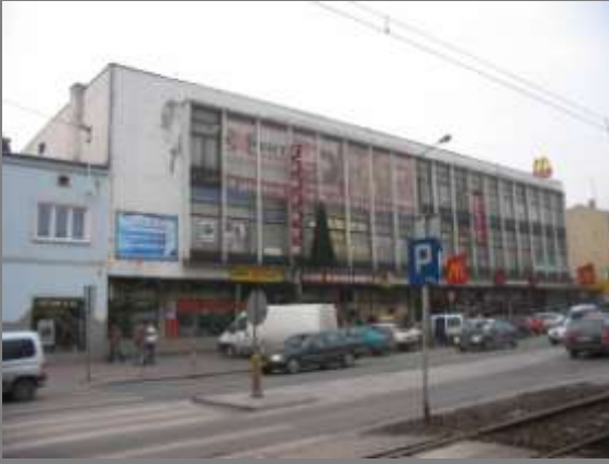
Dom Handlowy CENTRUM przed przebudową
